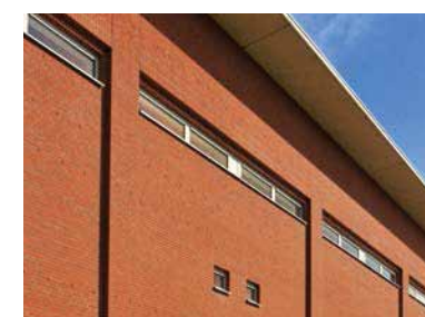
Zakład Uzdatniania Wody we Wrocławiu s. 20
